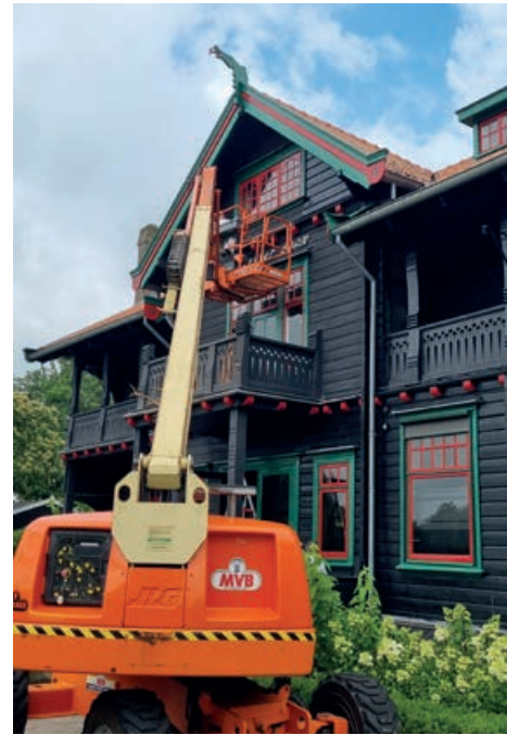
Alle werkzaamheden op hoogte werden met een hoogwerker uitgevoerd
